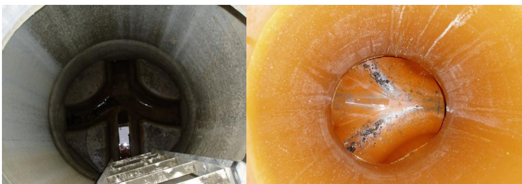
Figur 17 - Eksempel på nyere avløpskummer med definerte renneløp
