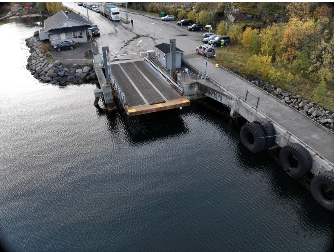
Figur 4-5: Dronefoto tatt mot ferjekai (Orion). Bergskjæringen som skal forlenges og det flate partiet der bygget tenkes etablert vises til høyre og bakerst i bildet.
