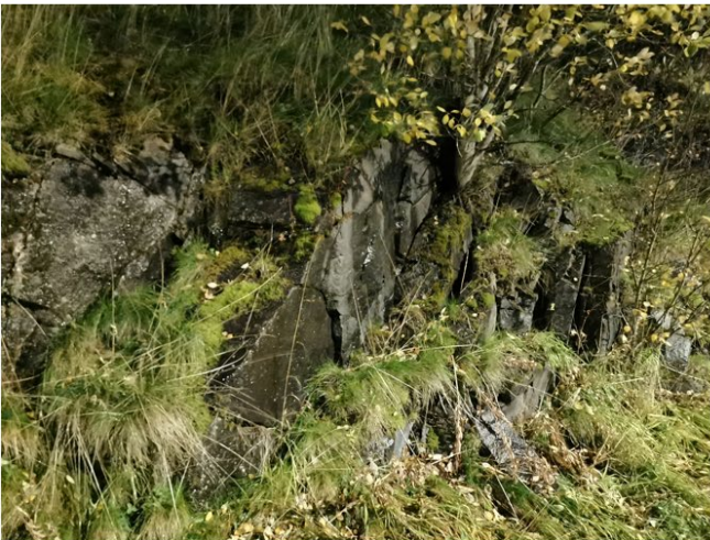
Figur 4-14: Bilder av eksisterende skjæring. Venstre oppe: Massivt berg, synlige og rette borpiper. Høyre oppe: Bergmasse gjennomsluttet av et plan som følger sprekesett S3. Venstre nede: Noe mer oppsprukket parti. Oppsprekking langs S1. Høyre nede: Overgang eksisterende skjæring mot vegetert og blokkig terreng ved planlagt ny bergskjæring.
