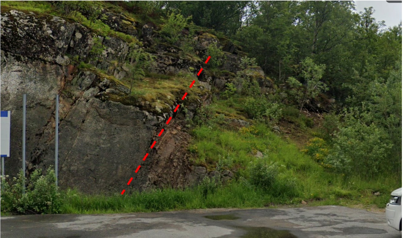
Figur 5-2: Overgang mellom massiv, eksisterende bergskjæring og mulig svakhetssone med mer oppsprukket og forvitret berg. Utklipp fra Google maps [8].
