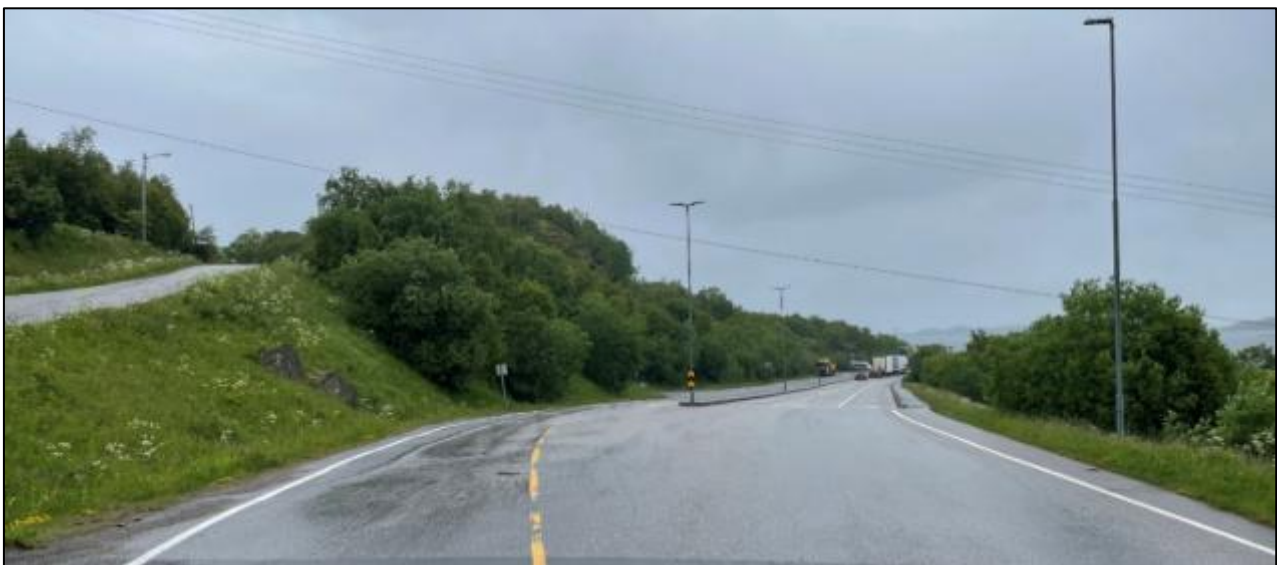
Figur 5. Oversiktsbilde som viser området. Bildet er tatt av NFK.
